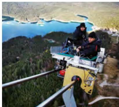
Visuelle Prüfung von Trag-, Zug- und Förderseilen.
